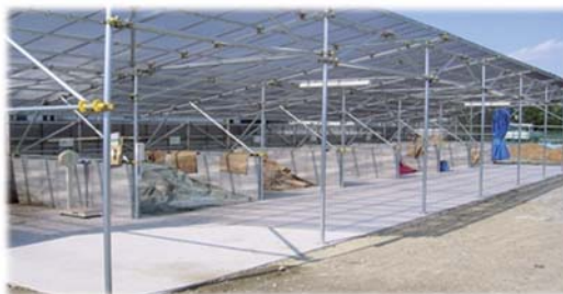
堆肥舎（生ごみの2次処理施設）
